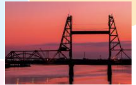
筑後川昇開橋の夕暮れ
