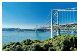
関門海峡大橋
